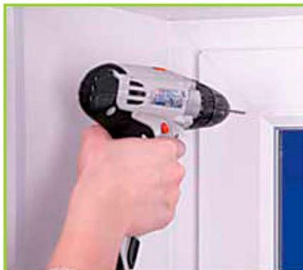
**Просверлить отверстия d2 мм.**
